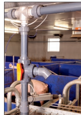
Пневматичен сферичен кран
